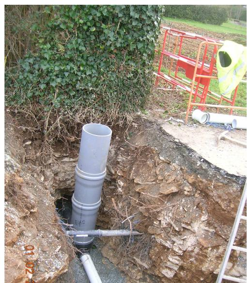
Figure 3 : réalisation d'un branchement
