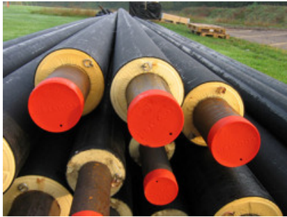
Tuyaux calorifugés pour réseau de chaleur
