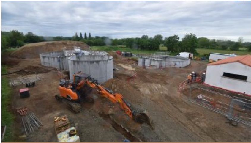
Figure 9 : travaux STEP Coulon (mai 2023)
