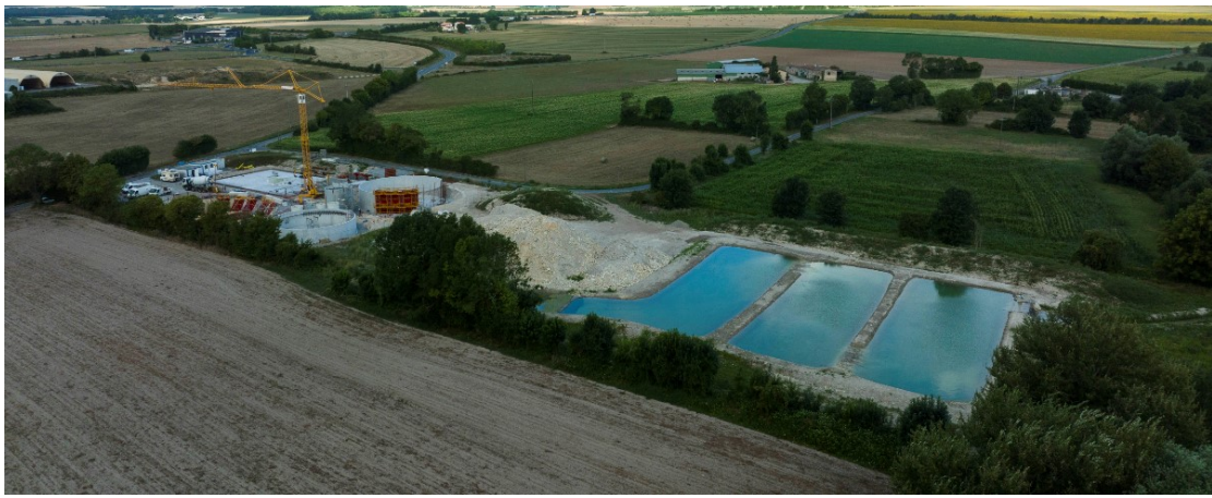
Renouvellement Station d'épuration de Mauzé/Mignon
