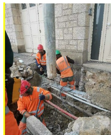
Figure 3 : renouvellement de réseau à Niort
