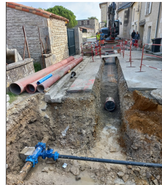
Figure 7 : réseau EP et AEP Frontenay RR
