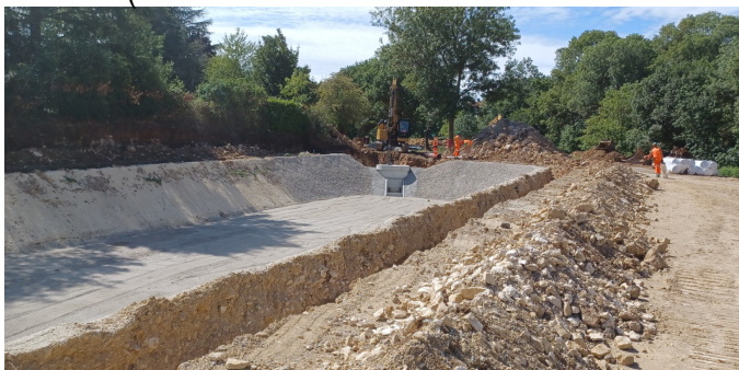
Figure 6 : terrassements bassins Sarrazine (Niort)
