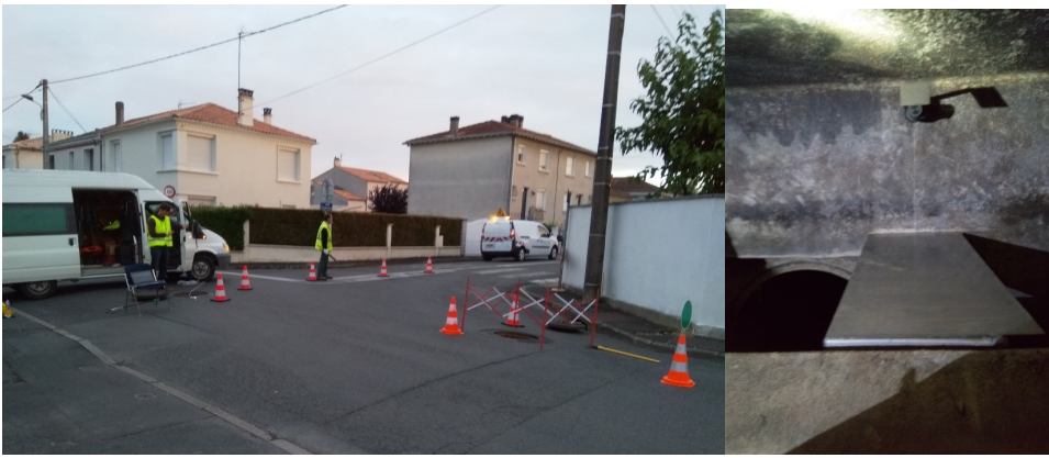
Contrôle avec étalonnage d'un point autosurveillance réseau (DO Jean Macé à Niort)
