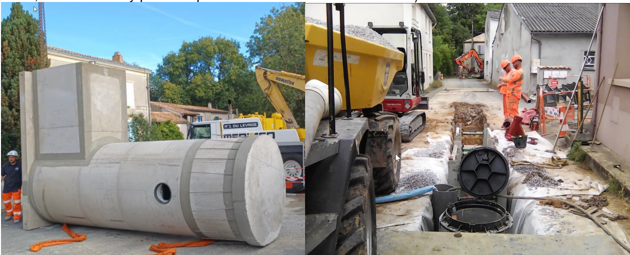
Pose du poste de refoulement de Montfaucon (St Hilaire la P)
