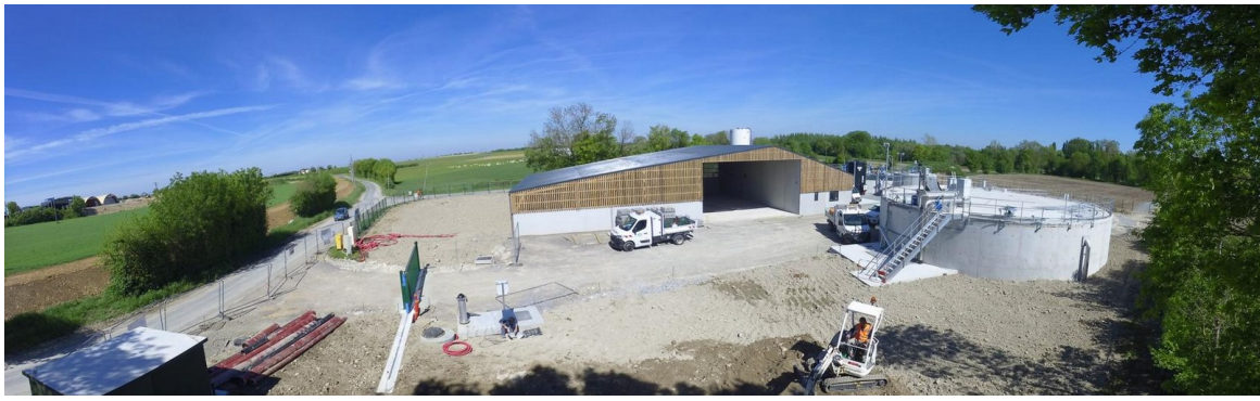
Figure 8 : travaux STEP Mauzé/Mignon (mai 2023)
