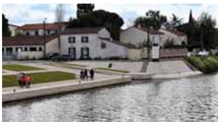
A50) Sèvre amont et aval, maillage des cheminements de qualité
