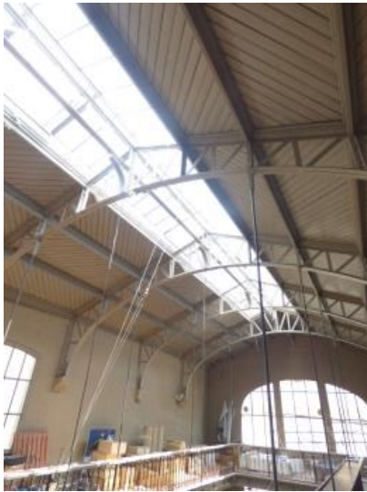
Poutrelles métallique et verrière
