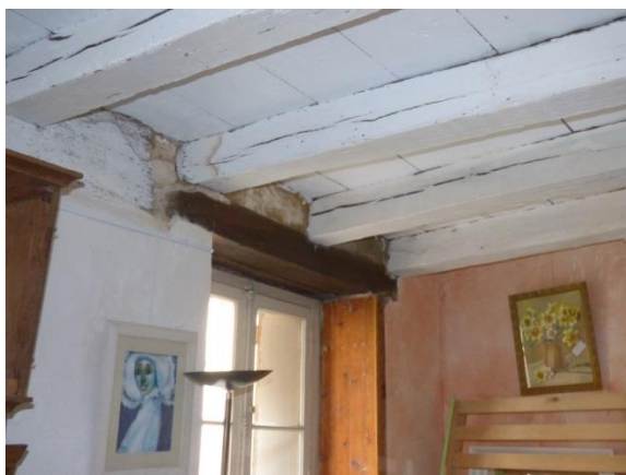
Infiltration au niveau de la tête de poutre et du linteau de la baie
