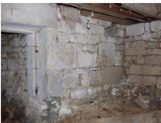
Accès avec gonds en fer forgé et encadrement en pierre de taille
