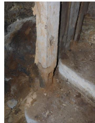
poteau bois dégradé
