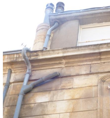
La surélévation et le déplacement de la gouttière et de la descente d'eau
