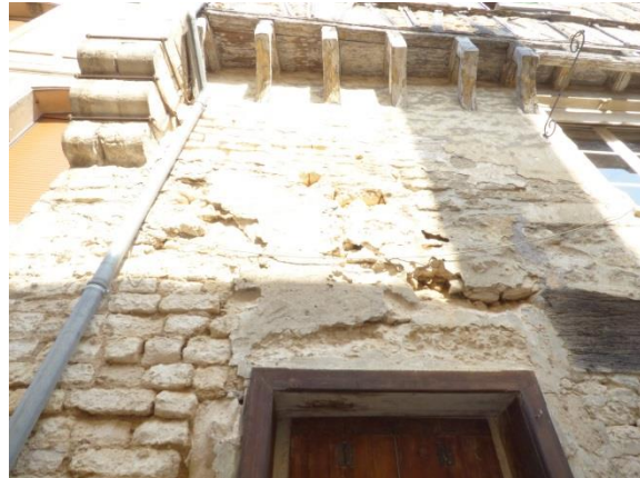
Enduit inadapté qui contribue à accentuer la dégradation de la maçonnerie.
