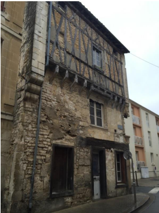
Façade sur la rue Saint-Gelais
