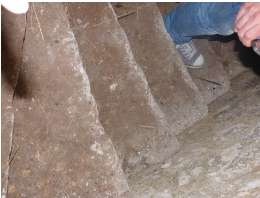
Escalier avec dalles en pierre
