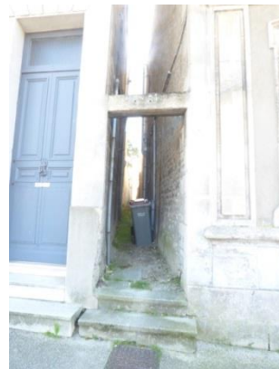
Marquage de l'entrée Place de la Brèche
