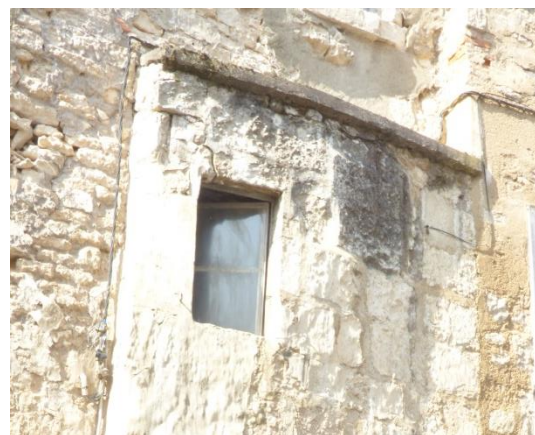
Toiture ciment – problématique de ruissellement (absence de larmier)
