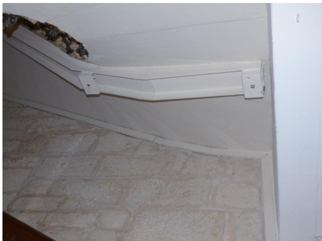
Les tirants de l'escalier
