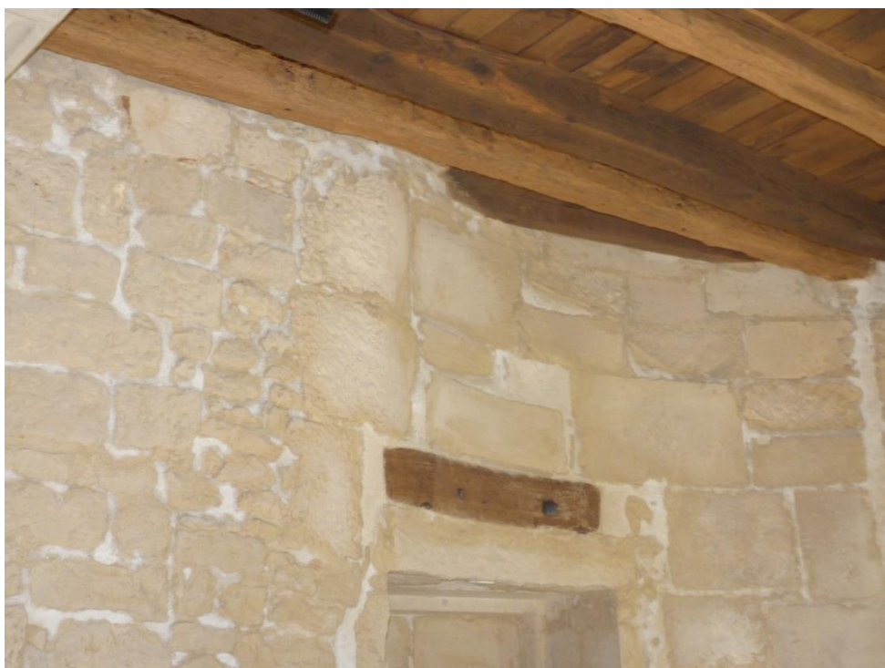
Trace de l'escalier grande pièce 1
