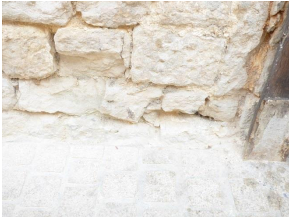
Dégradation de la pierre qui devient poudreuse.
