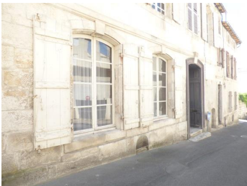
Façade sur la rue de la Vielle Rose
