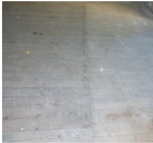
Plancher de la grande pièce 2
