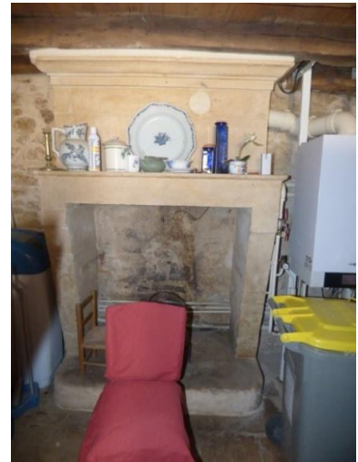
cheminée de la buanderie (d'origine)
