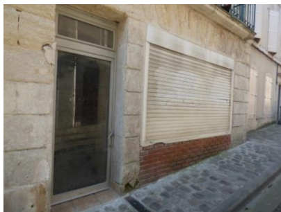
Rue Saint-Gelais Des commerces fermés et des étages dégradés
