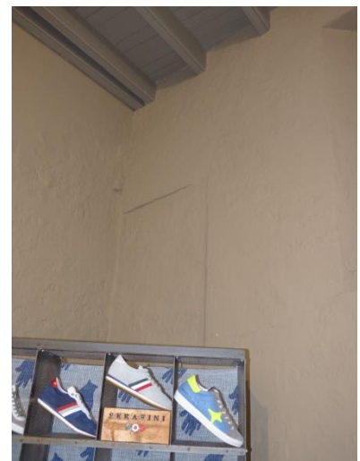
Ancienne ouverture bouchée
