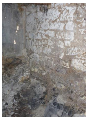
Partie de maçonnerie sur le rocher
