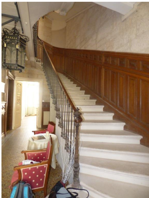
Escalier, volée depuis le rez-de-chaussée
