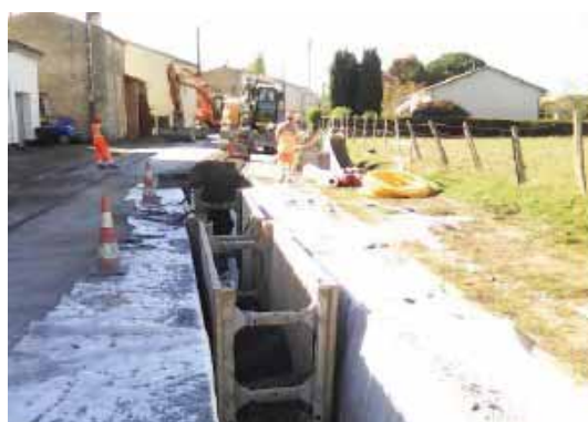
Figure 3 : renouvellement de réseau à Coulon
