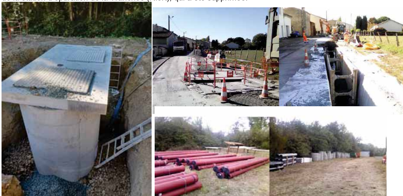
Pose du poste de refoulement de la Tranchée (Niort)
