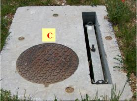
La manœuvre des 3 vannes se fait par l'utilisation d'une clé d'intervention, à actionner dans le sens horaire jusqu'à fermeture complète. La vanne C est protégée par une plaque métallique qu'il suffit de soulever verticalement pour accéder au pas de vis.
