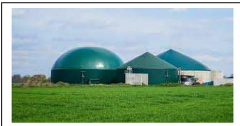
La méthanisation agricole permet de produire du méthane qui peut être soit injecté sur le réseau de gaz, soit brûlé sur un moteur à gaz qui produit électricité et chaleur selon le principe de la cogénération.
