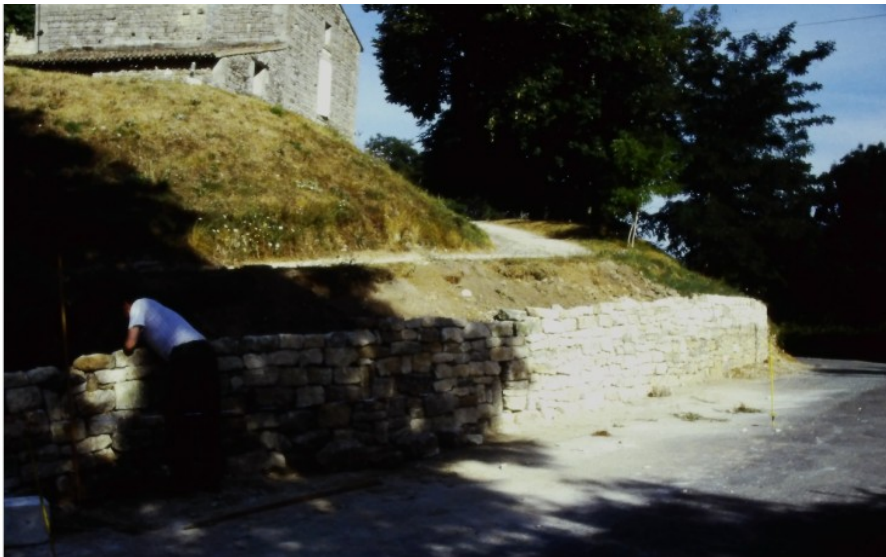
Fig. 10 Vue du muret en 1998 en phase de remontage
