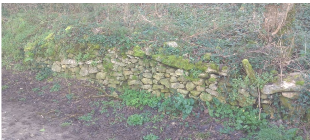
Fig. 14 : Vue 3 - Trace du muret et mise en évidence de l'appareillage cible ?
