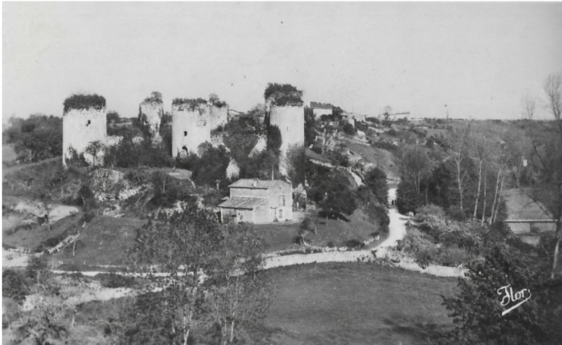
Fig. 6 Environnement du château dans les années 1930 : la parcellisation est très marquée.
