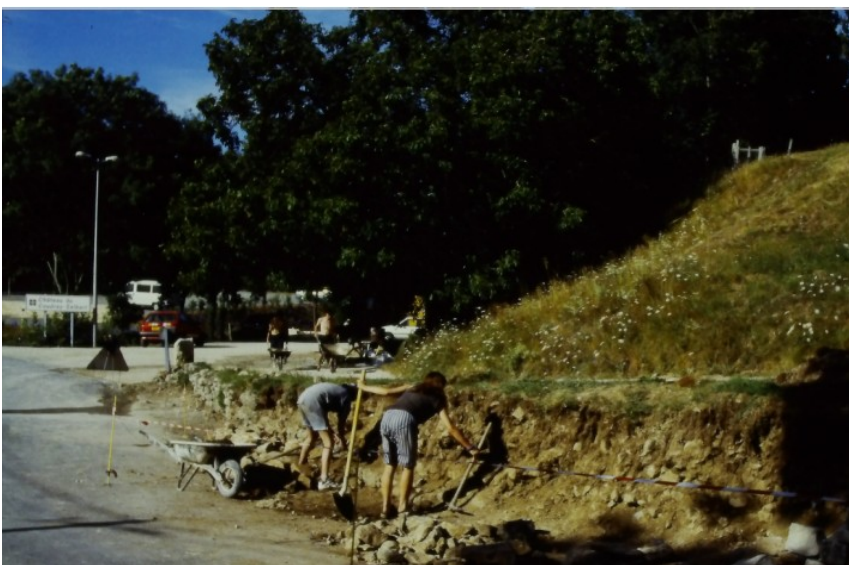
Fig. 9 Décapage du muret en 1997
