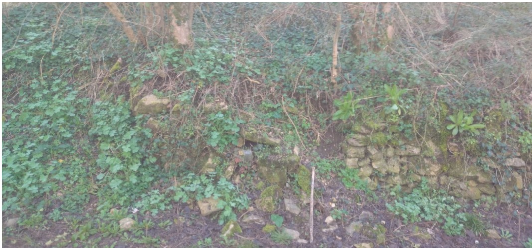
Fig. 12 : Vue 1 - Trace du muret de petit appareil
