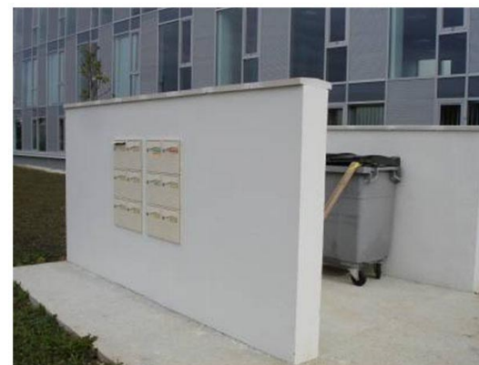
Intégration des boîtes aux lettres dans les murets cachant les containers
