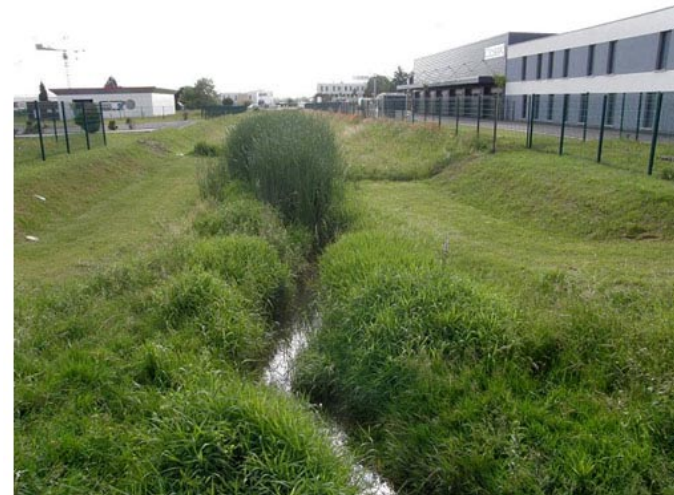
Exemples d'aménagement de bassins d'orage en coulée verte
