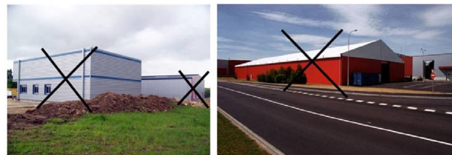
Eviter les couleurs claires, vives, contrastées et les détails colorés ne correspondant pas à des éléments architecturaux
