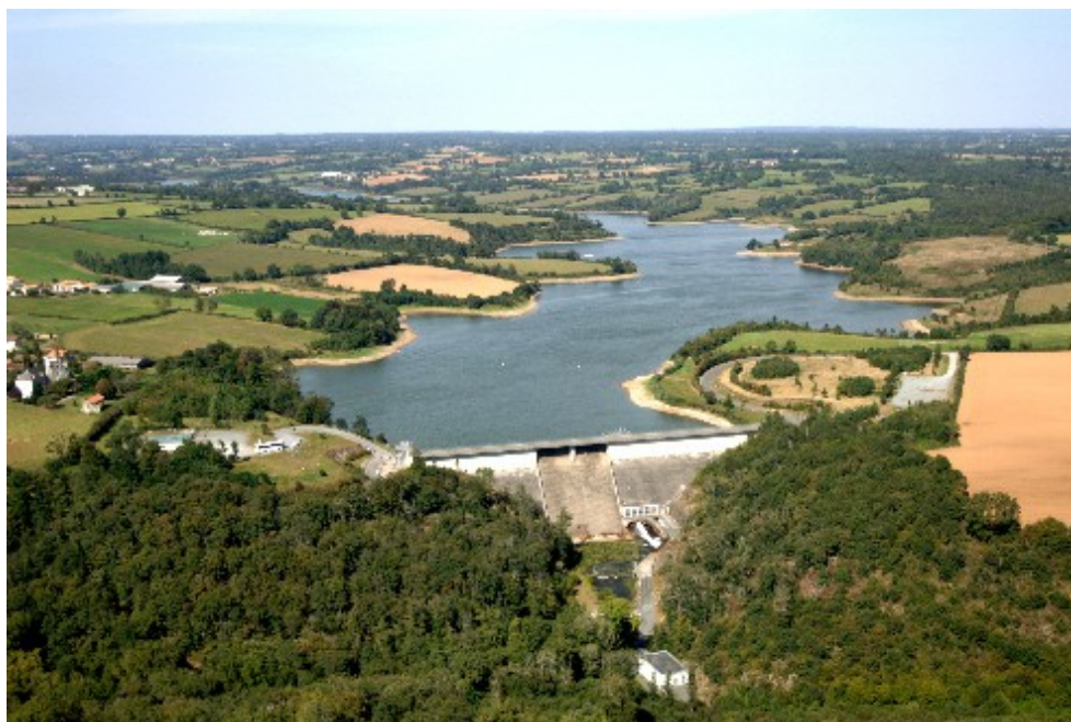
Barrage de la Touche-Poupard
