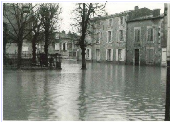
Crue de décembre 1982 – carrefour rue de l'Ecole Militaire à Saint-Maixent l'Ecole Source : commune de Saint-Maixent l'Ecole
