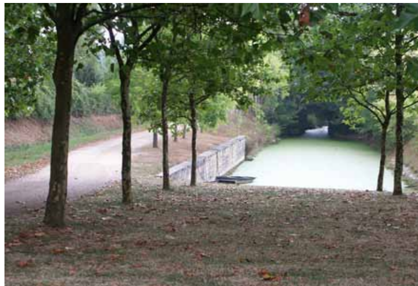
Aménagement de petits ports à Saint-George de Rex : engazonnement et pavage
