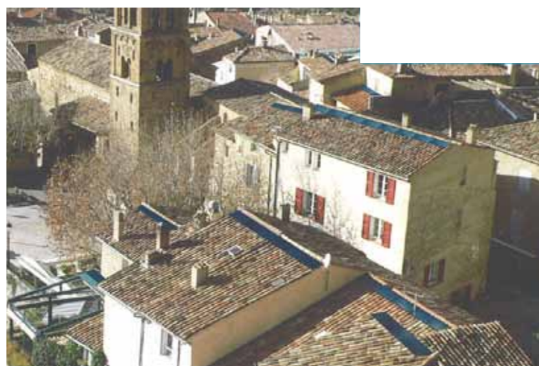
Solution acceptable en bandeaux des panneaux solaires
