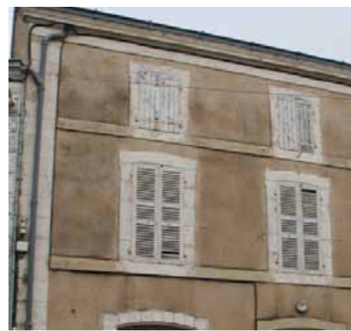
Moellons enduits sur maison d'habitation
