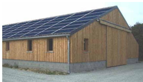
Image 1 : implantation de capteurs sur 100% de la couverture
