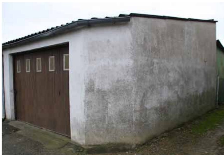
garages et hangars
