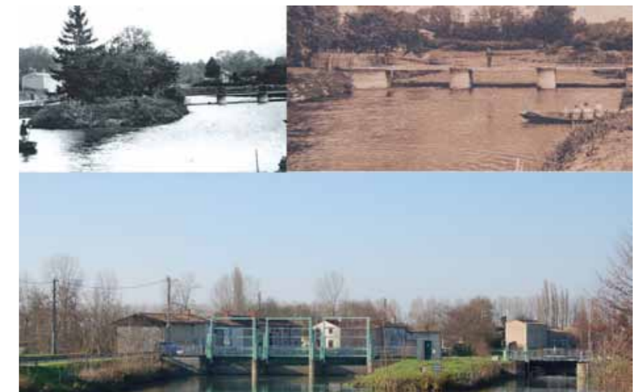
2. Pont et écluse des Bourdettes, hier et aujourd'hui.
