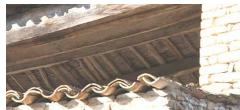
Roseau en support de tuiles
