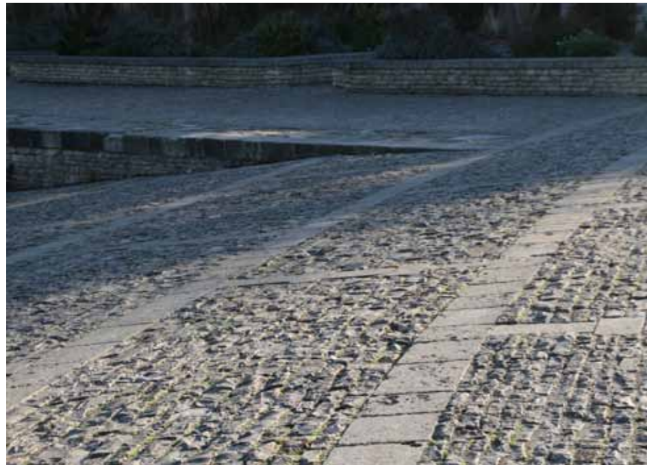
Pierres sur chant et grandes dalles de pierres au port d'Arçais
