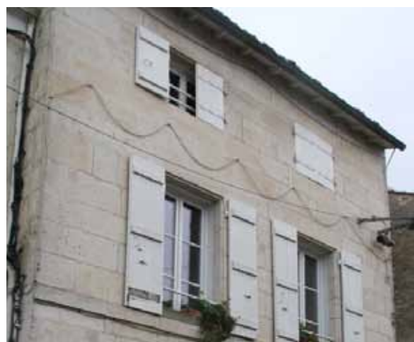
Façade en pierre de taille sur une maison de bourg
