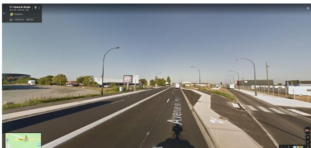
ENTREE DE VILLE PAR LA D948, ARRIVEE AU NIVEAU DE LA ZONE COMMERCIALE TERRE DE SPORT
