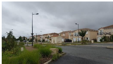
RUE DES CORNOUILLERS, CHAURAY
