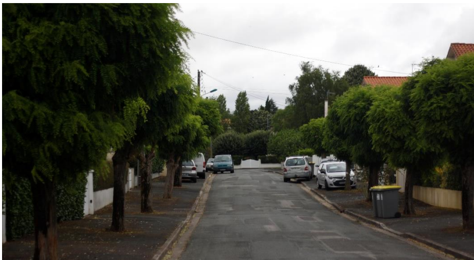
LARGES VOIES DE CIRCULATION ET DE STATIONNEMENT, RUE DU FIEF CHEVALIER, AIFFRES
