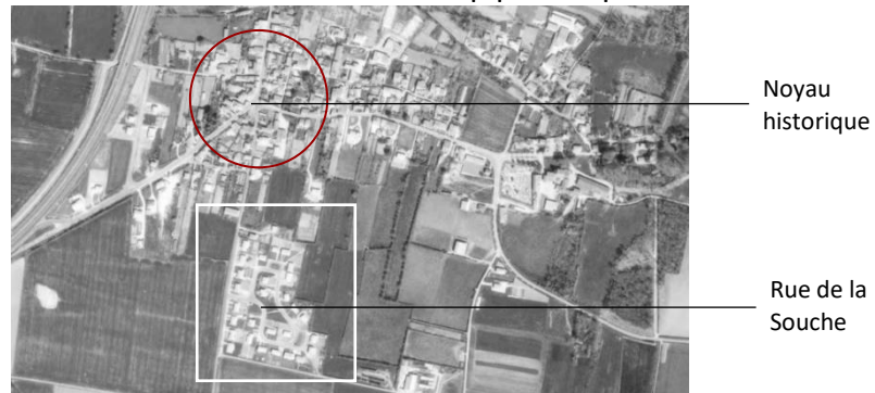
VUE AERIENNE D'EPANNES EN 1984 – SOURCE : REMONTERLETEMPS.IGN.FR
