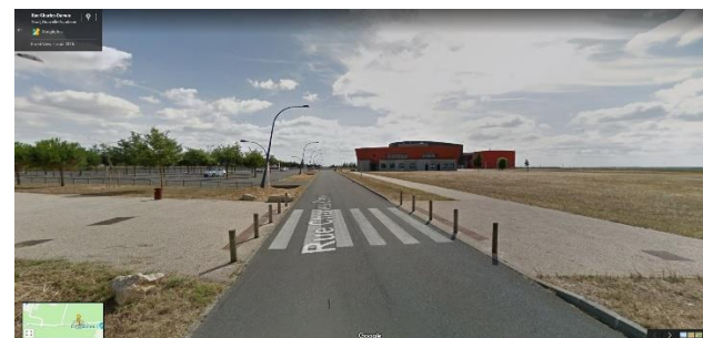
AMENAGEMENT DE CHEMINEMENT DOUX AUX ABORDS DE LA SALLE DE SPECTACLE
