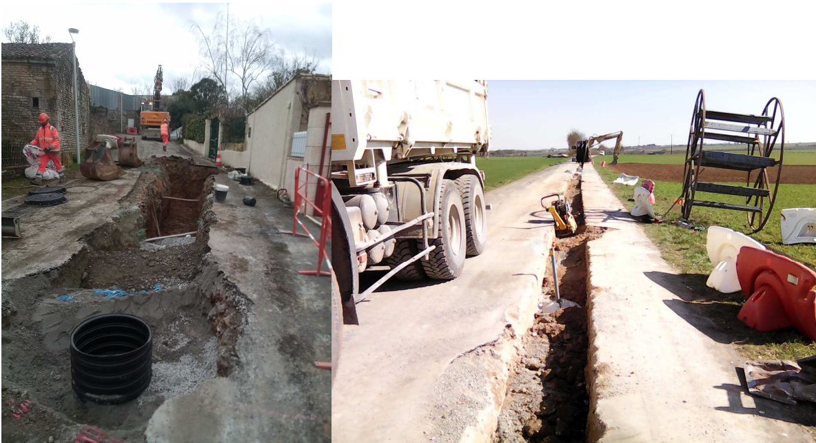
Renouvellement réseau Aiffres
