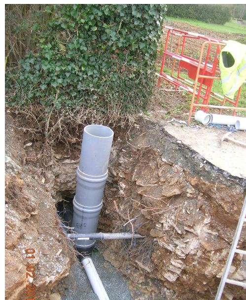
Figure 3 : réalisation d'un branchement
