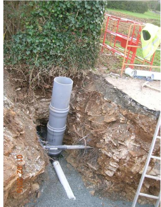
**Figure 4 : réalisation d'un branchement**
