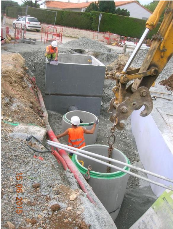
Figure 7 : pose d'un réseau eaux pluviales
