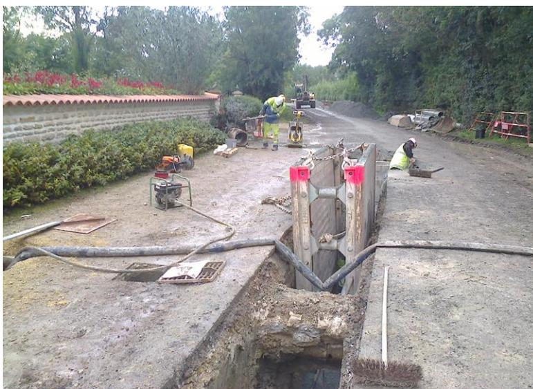
Figure 6 : pose d'un réseau EU avec blindage
